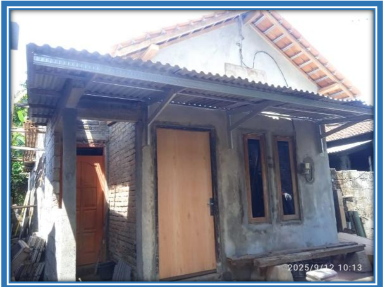
Program Rehab Rumah Tidak Layak Huni GAKIN
